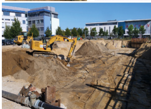
Baugrube für das GO:IN II
